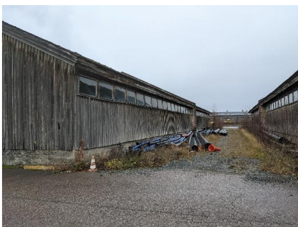
Yleiskuva rakennuksista ja vierustoista rakennuksien välistä eteläpäädyistä
