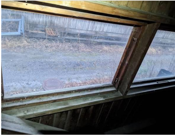
Yleiskuva ikkunasta sisäpuolelta
