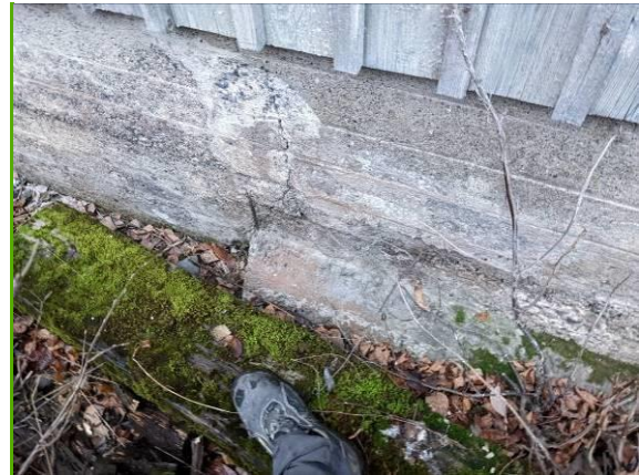
B-varasto, itä: kehän kohdalla näkyvissä mahdollinen antura
