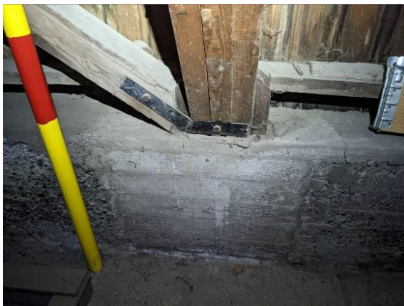
Kehän liitoksen kohdalla erotettavissa erillinen ja/tai parempilaatuinen valu
