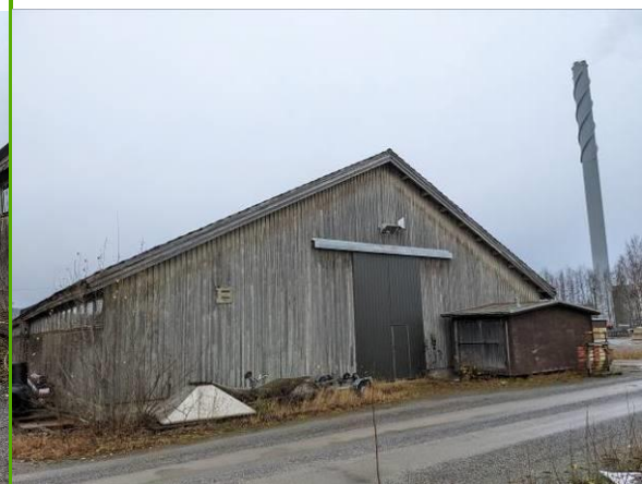
Yleiskuva pohjoispuolelta rakennuksesta ja alueesta
