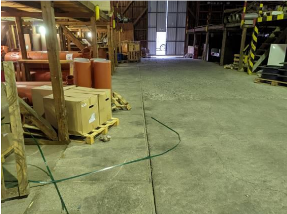
B-varasto: betoni kiviaineksella kulkuväylällä
