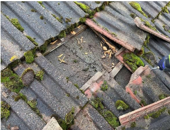
C-halli, länsi: tiilikate painunut, ruoteet lahonneet
