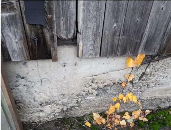
B-varasto, etelä: sokkeliin valettu paikkavalu
